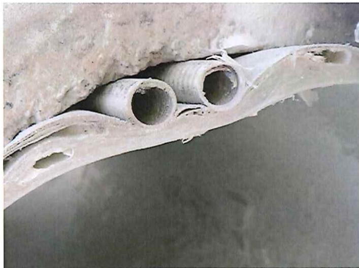
Abbildung 1: Verlegte Schutzrohre im Kanal hinter dem Liner [1]
