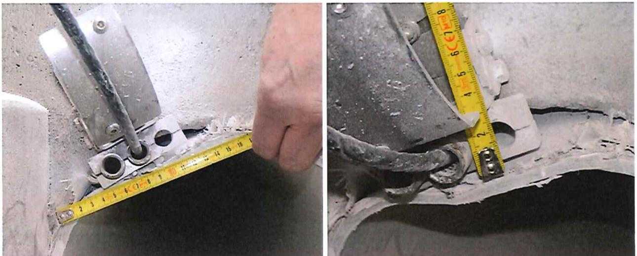
Abbildung 2: Spanneinrichtung im Kanal hinter dem Liner mit Vermaßung [1]
