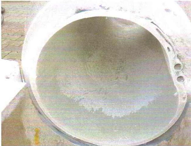
Bild 23: Saertex Liner in der Versuchsstrecke mit Schutzrohren
