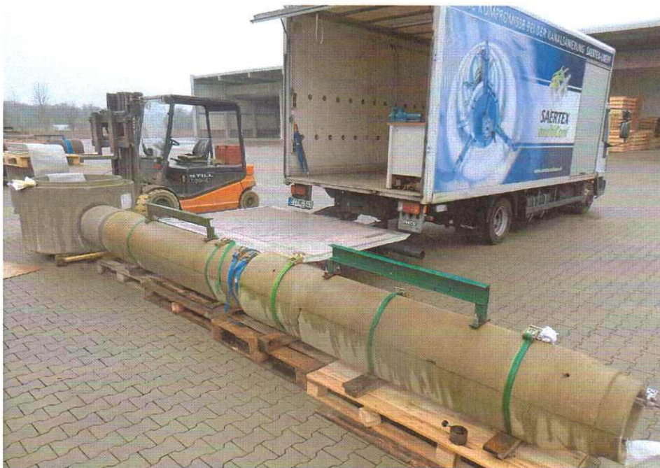
Bild 1: Versuchsstrecke aus Betonrohren mit installiertem Glasfaserkabel
