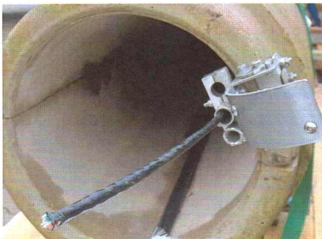
Bild 6: Verwendetes Glasfaserkabel im Schutzrohr
