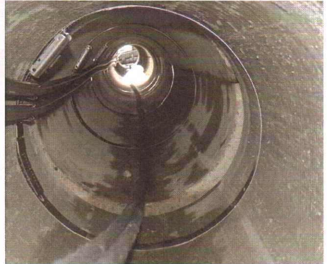
Bild 3: Blick in die Versuchsstrecke mit Spannbändern für die Schutzrohre
