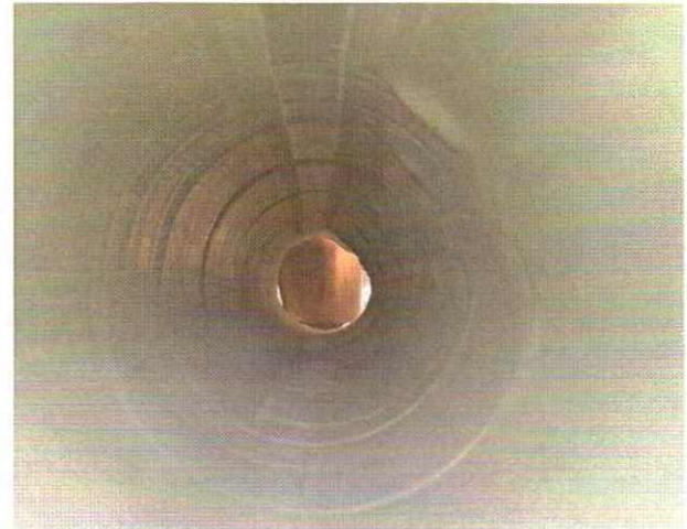
Bild 24: Blick in den ausgehärteten Saertex Liner
