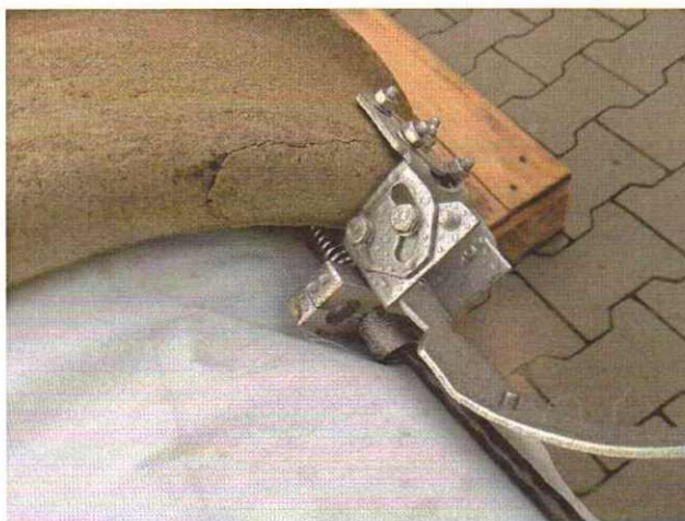
Bild 16: Aufgestellter Schlauchliner im Bereich der Spanneinrichtung am Rohrende
