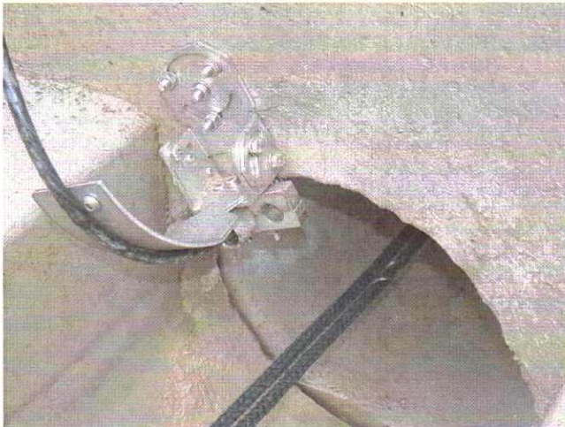
Bild 4: Befestigung der Schutzrohre im Schacht mit Spanneinrichtung (Schachtanker)
