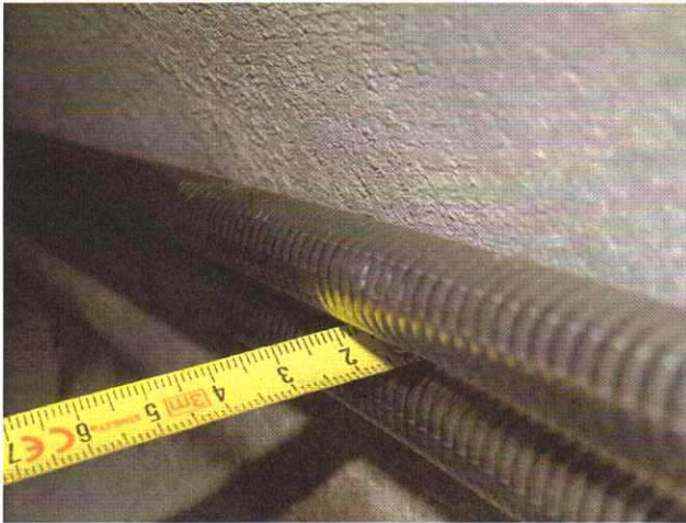
Bild 10: Abstand der Schutzrohre zur Rohrwand
