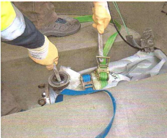
Bild 14: Einbau des Drucktopfes am Liner-Ende im Schacht
