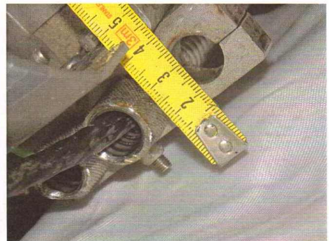
Bild 17: Spanneinrichtung am Schlauchliner während des Aufstellens
