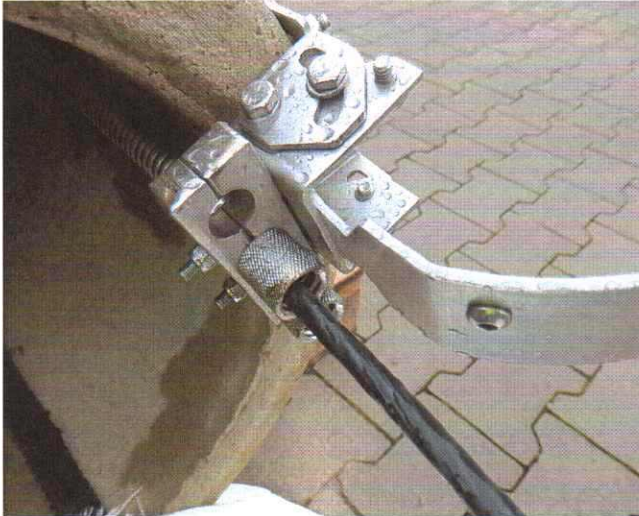
Bild 2: Befestigung der Schutzrohre am Rohrende mit Spanneinrichtung (Schachtanker)
