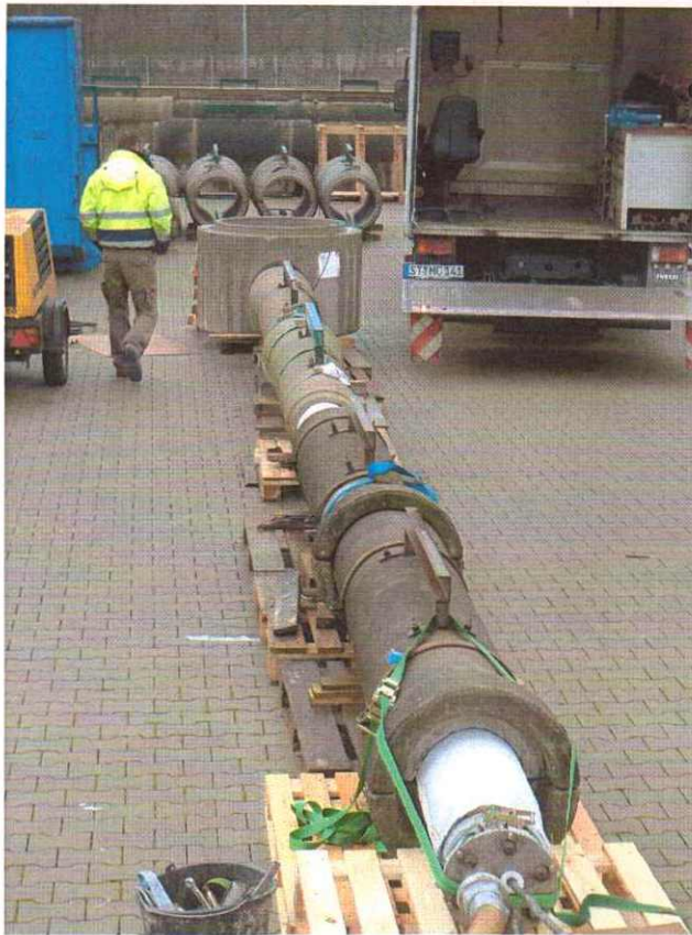
Bild 20: Aushärtung des Saertex-Liners
